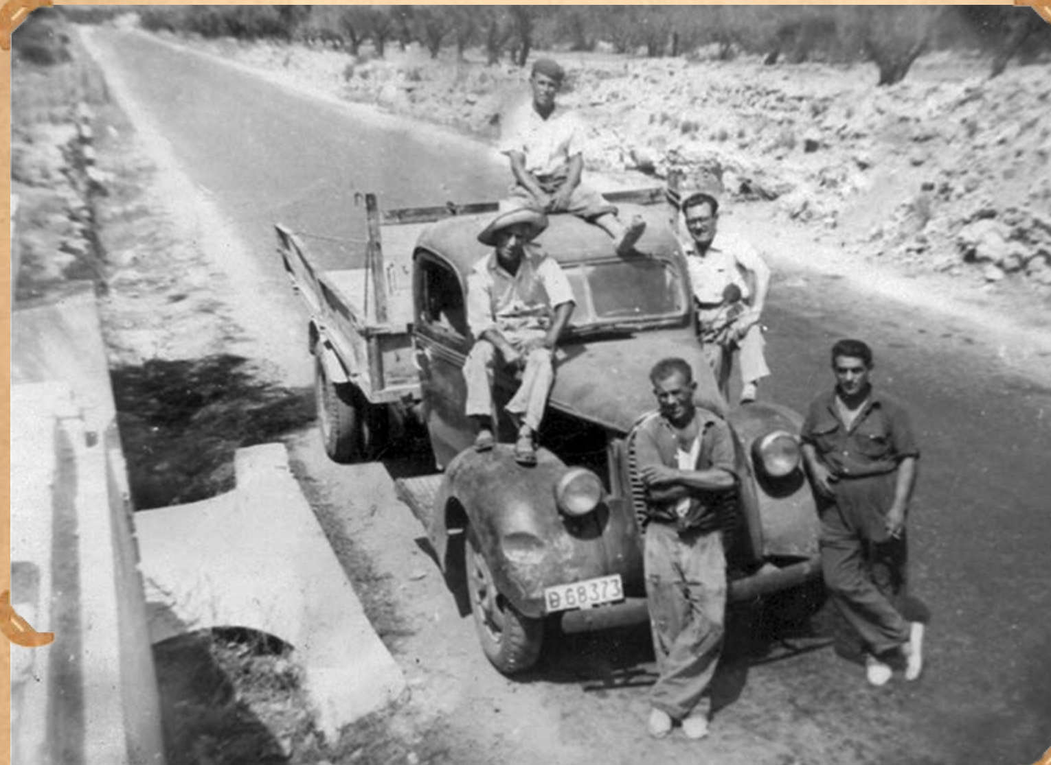
Brigada de peons que construïen el nou pont de la Batalla, a la carretera nacional 340, l'any 1954. Entre d'altres, hi ha Joan Alcarraz, Francisco Alcarraz i l'encarregat, el Sr. Pepito.
